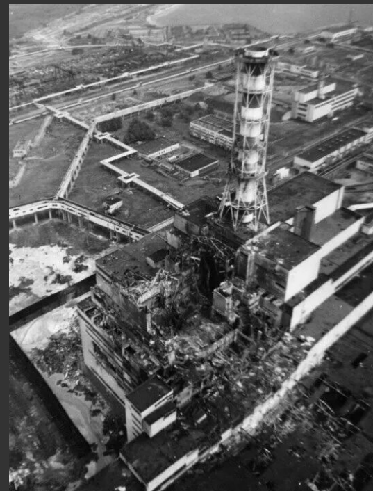
Разрушенный 4-й энергоблок ЧАЭС
